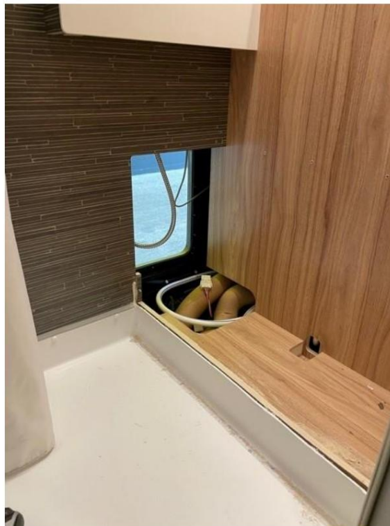
Sprchová vanička zkrácená a platforma postavená pro základnu C1
