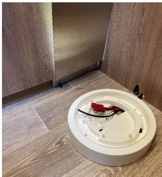
Kulatá základna přišroubovaná a vložený kabel
