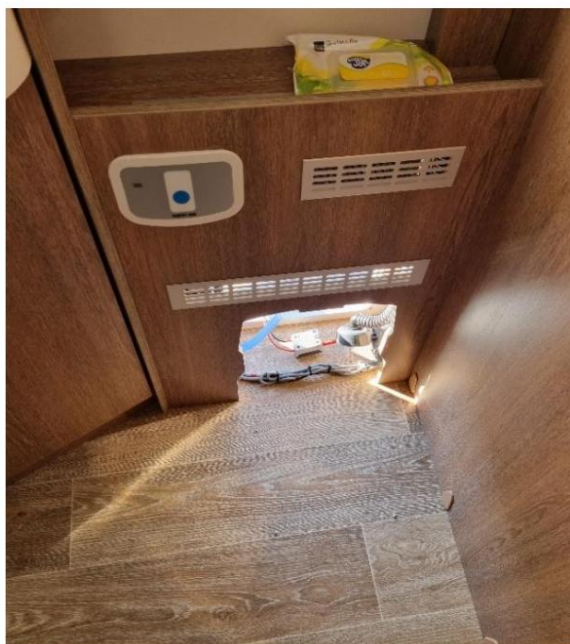
Servisní otvor po vyjmutí kazetového WC
